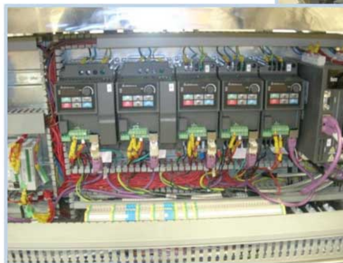
ПЛК DELTA DVP-SA2 с модулями расширения и блоком питания DVPPS02
