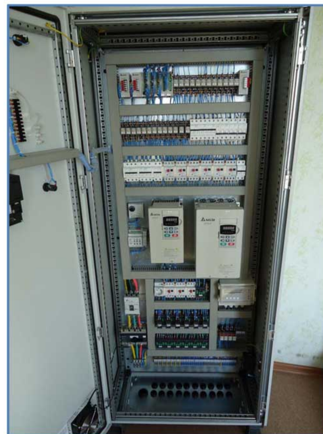
Шкаф управления установкой мощностью 200 м 3 /сут. с 2 ПЧ VFD-F и панелью DOP-B
