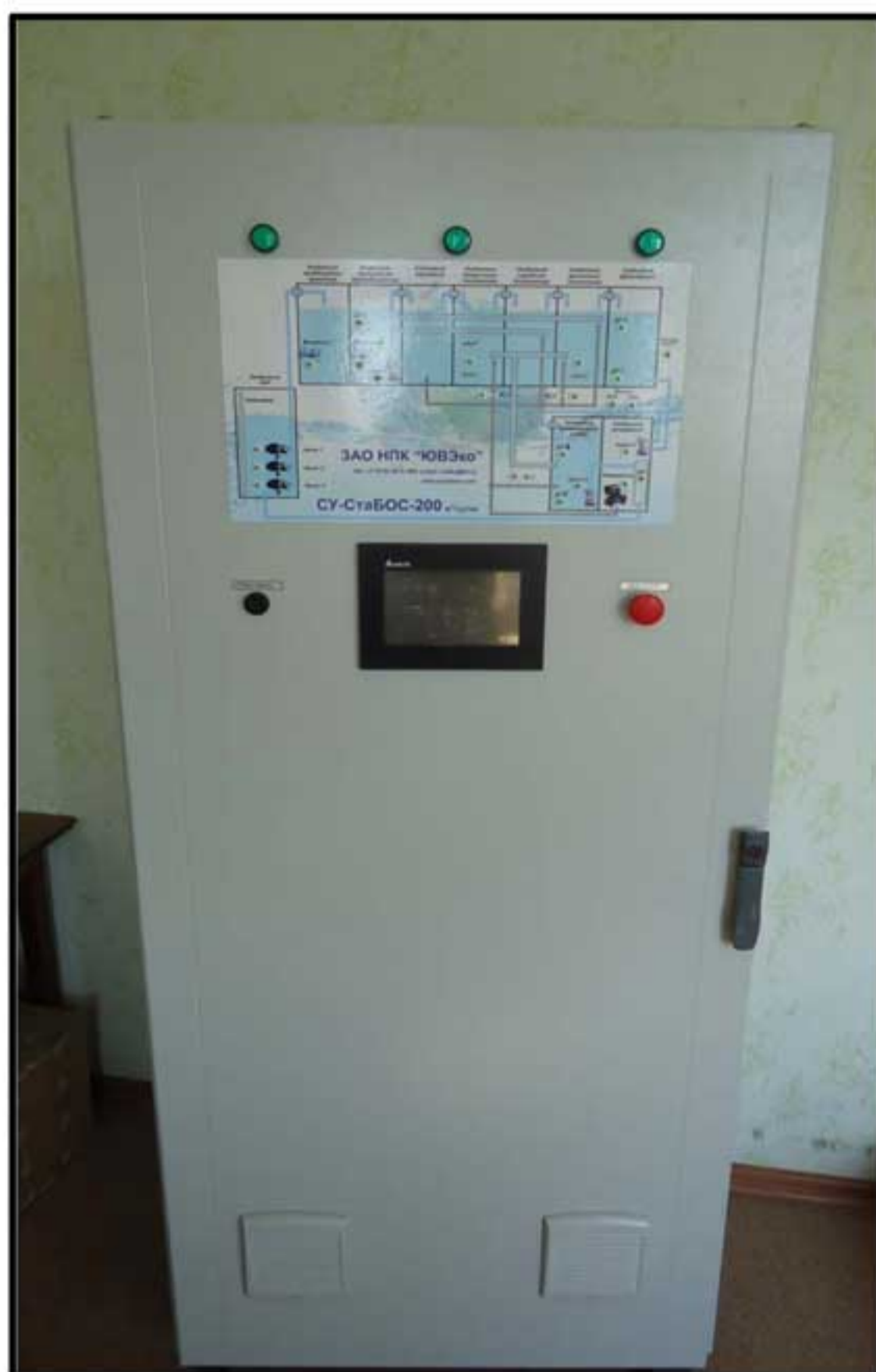
Шкаф управления установкой мощностью 200 м 3 /сут. с 2 ПЧ VFD-F и панелью DOP-B
