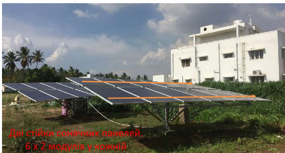
Малюнок 8. Рекомендована установка сонячних панелей.
