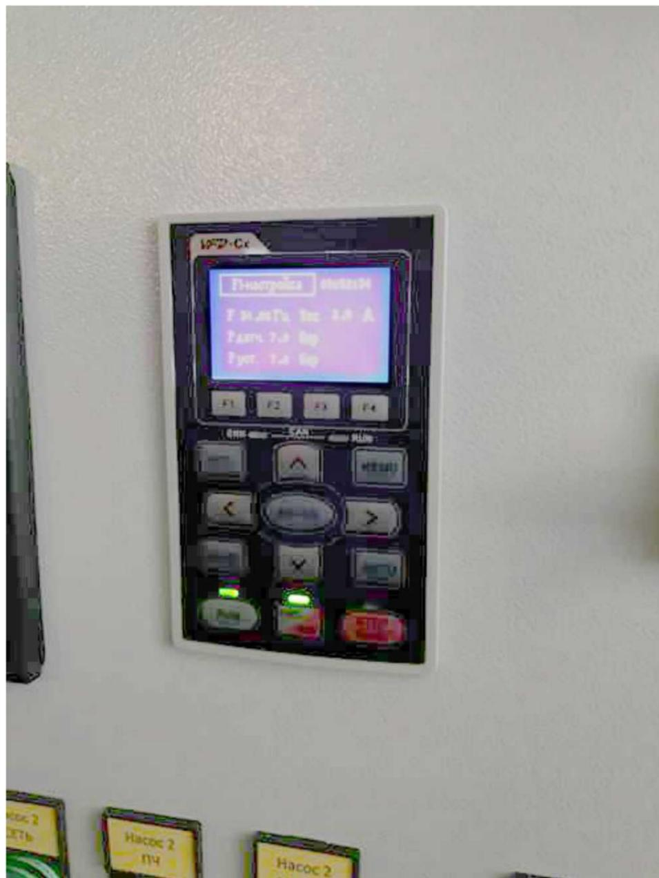
Пульт преобразователя частоты вынесен на лицевую панель – управление повысительными насосами
